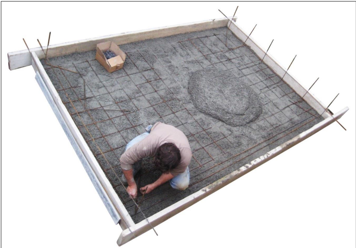
Mise en place du ferrailage
